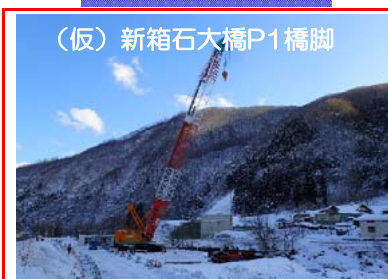
④施工：安藤・間
