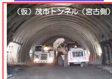
⑥施工：前田建設工業
