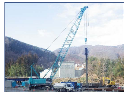
土留・仮締切工施工状況
