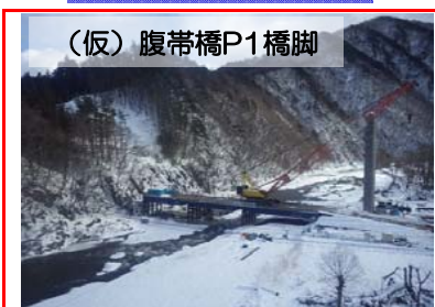
⑨施工：大豊建設
